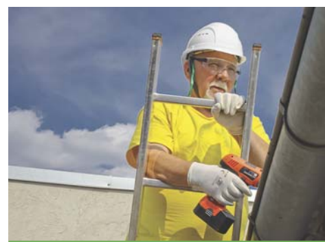
Stój zawsze przodem do drabiny, między podłużnicami i nie wchodź na 3 ostatnie szczeble.
