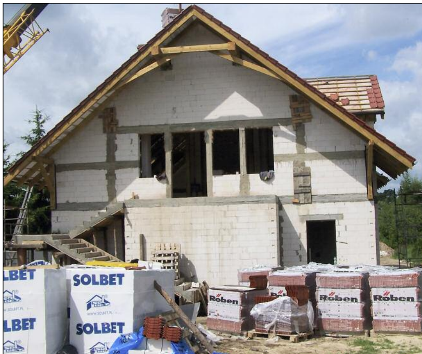
Przedszkole w budowie.
